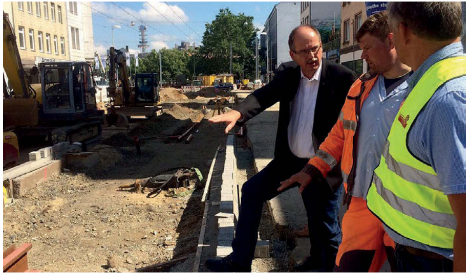
Stefan Körzell im Gespräch mit Kollegen der IG BAU auf der Tram-Baustelle Hannover Steintor
